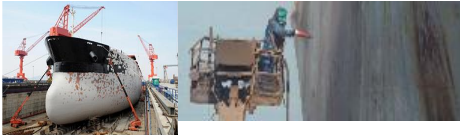
新造および修理船の表面処理
